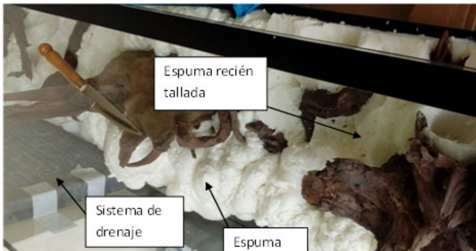
Figura 3. Espuma de poliuretano con elementos suspendidos y macetas. Tallada a cuchillo
